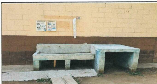
Foto 3: AMPLIACIÓN DE LAVAMANOS Y COLOCACIÓN DE TINACO
