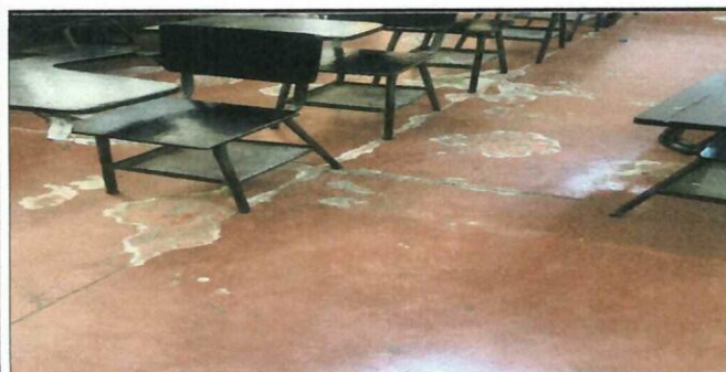
Foto 5: REPARACIÓN DE PISOS
