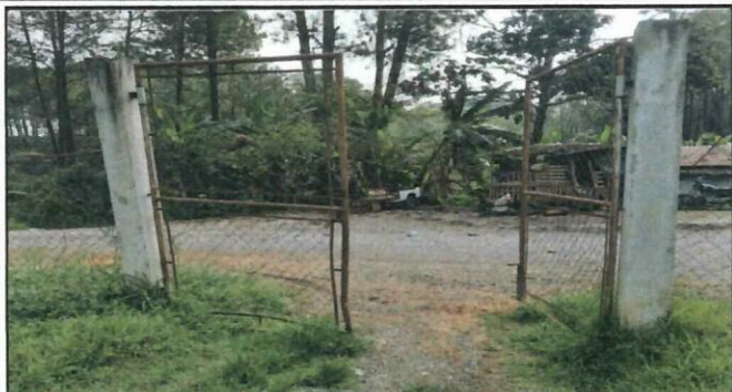
Foto1: REPARACIÓN DE PORTON Y PARALES DEL MISMO .
