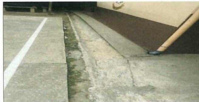
Foto 6: COLOCACIÓN DE REJILLAS
