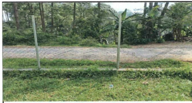
Foto 4: REPARACIÓN DE CERCA PERIMETRAL
