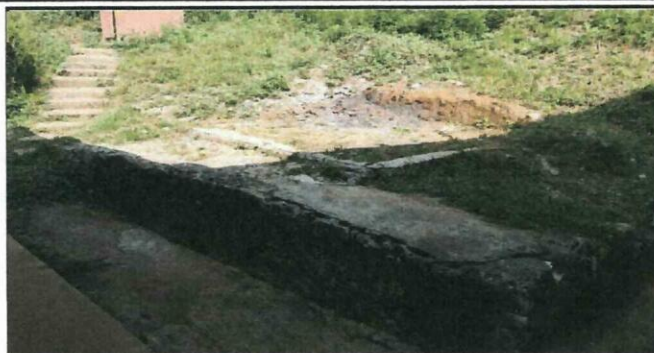
Foto 2: AMPLIACIÓN DE BAÑOS
